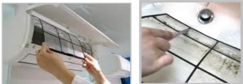
エアコンフィルターと熱交換器(冷却フィン)の掃除をこまめに行ってください。汚れを放置すると、埃や汚れが詰まり、故障の原因になるだけでなく、様々なトラブルを引き起こします。
